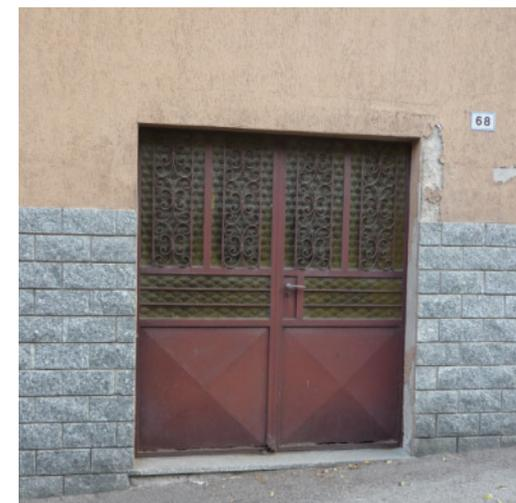
Il serramento è infatti in contrasto con gli stilemi del nucleo antico e degli edifici di derivazione rurale. L'uso di vetri, il modulo estraneo al contesto e la modalità impropria di rivestimento del basamento dell'edificio (piastrelle lapidee) ne fanno un elemento perturbatore del nucleo storico.
