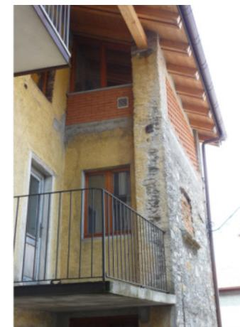
Due tipologie di balcone a confronto. Il tipo originario a ballatoio (struttura lignea originaria con tavola fermapiEDE e a protezione delle mensole) e un tipo recente in cemento armato incoerente con il centro storico (struttura portante e ringhiera incongrui).
