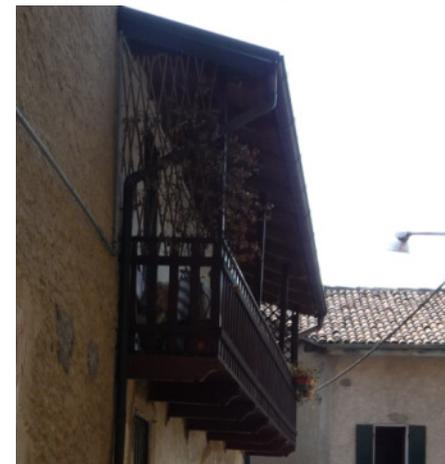
Balcone ligneo del tipo a "lobia", ovvero con tiranti in legno che collaborano con la struttura di copertura per il sostegno del balcone.
