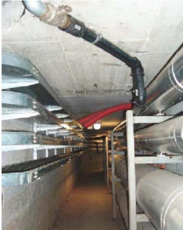
Esempio di galleria a sezione rettangolare attrezzata con le staffe per la posa delle reti
